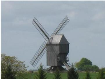
Le **moulin sur pivot**, ou chandelier, possède un corps en bois qui s'oriente lui aussi selon le vent. Il repose sur un socle en bois formé par deux poutres en bois que l'on appelle « la croisée », et par des liens obliques. Il était facilement démontable mais aussi facilement détruit. Il fut utilisé en temps de guerre comme point de repère et aussi comme moyen de communication par signaux, comme ce fut le cas du moulin de Valmy lors de la célèbre bataille éponyme (1792).
