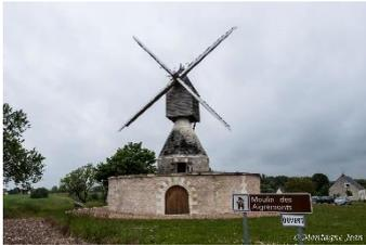
Le **moulin cavier** est un intermédiaire entre les moulins précédents puisque seul tourne le corps mobile en bois supportant les ailes et le système d'engrenage : la « hucherolle ». La construction est plus basse, parfois semi-enterrée pour servir de pièce de cave, voire d'habitation pour le meunier (la masse). L'échelle qui sert d'accès à la hucherolle est fixée et joue le rôle de timon. Selon la tradition, un âne était
